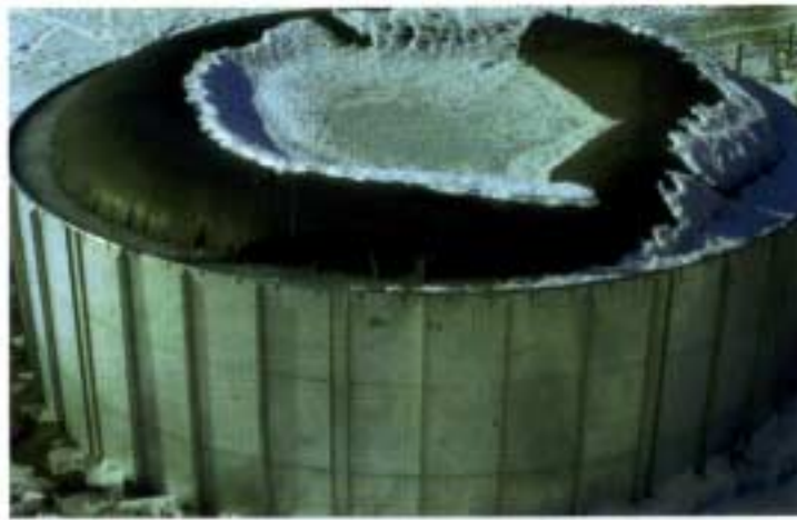
Figure 6. – Une fosse fermée constituée d'un conteneur cylindrique en acier placé sur du sable. Elle contient un sac fermé. Un système de remplissage, de brassage et d'évacuation a spécialement été conçu pour cette fosse.
