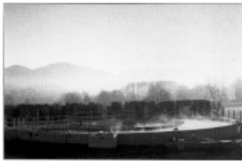
▲ Chenal annulaire d'une station d'épuration avec son décanteur central (A Héduit, Cemagref)
