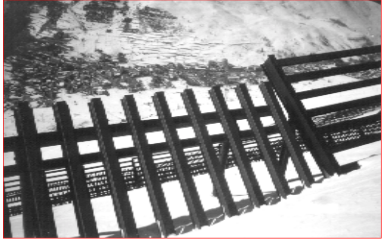
Photo 2. – Graves dégradations dans une rangée de filets. Au premier plan (en bas à droite) un câble d'ancrage est sectionné ; au second plan, deux poteaux sont pliés (photo Y. Queffélec, Cemagref).
