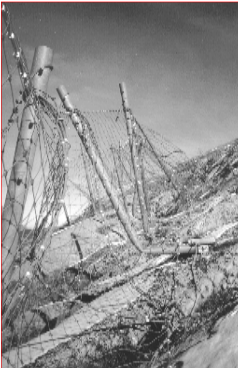
Photo 2. – Graves dégradations dans une rangée de filets. Au premier plan (en bas à droite) un câble d'ancrage est sectionné ; au second plan, deux poteaux sont pliés (photo Y. Queffélec, Cemagref).
