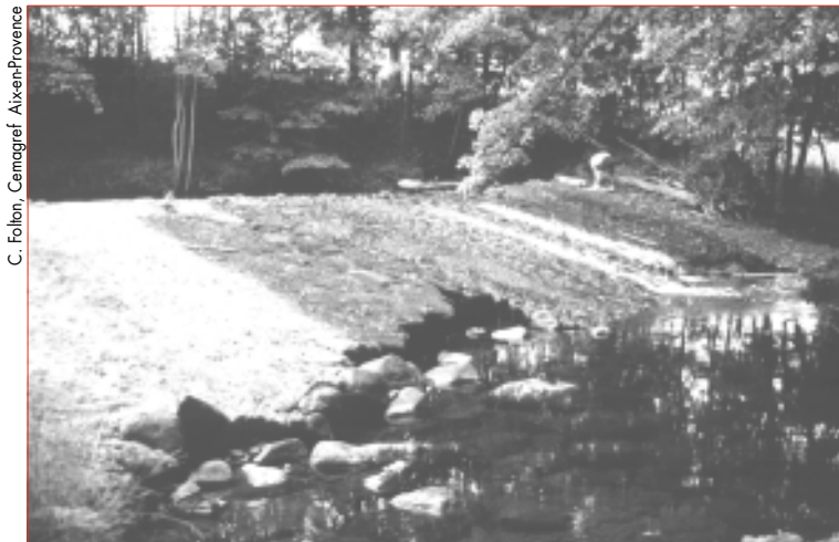
▲ Photo 2. – Seuil à profil triangulaire en conditions d'étéage estival - Déstructuration du pied du parement aval en pierres maçonnées.
