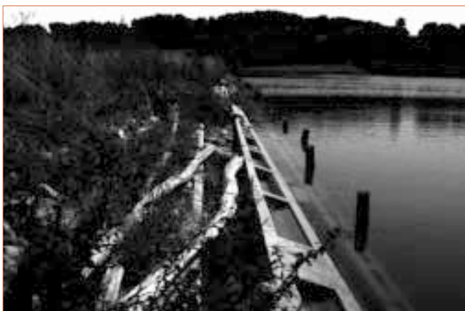
▲ Photo 3. – Barrage de Manadé. Un exemple de confortement rustique sur un talus très dégradé par les vagues.
