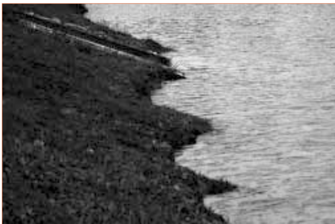
▲ Photo 1. – Barrage de Lussan. Talus amont marqué par le battillage.
