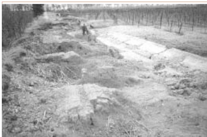
◀ Exemple de brèche dans une digue après la crue de 1997. On observe nettement l'éboulement du mur de soutènement.
