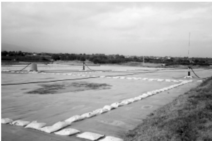
▲ Photo 4. – Exemple de couverture provisoire avec un géofilm pour la gestion des eaux de surface (photo Y. Matichard).
