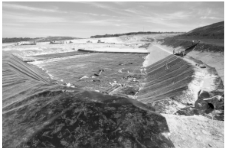
▲ Photo 1. – Construction d'un centre de stockage de déchets (photo Y. Matichard).
