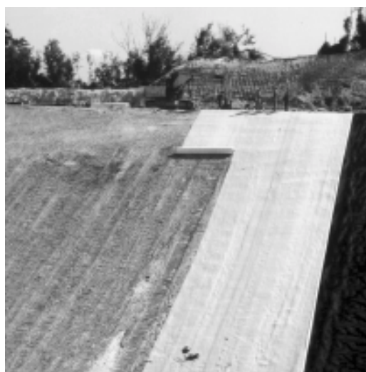
◀ Photo 3. – Exemple de mise en oeuvre de géosynthétique bentonitique sur les talus d'un centre de stockage de déchets (photo Y. Matichard).
