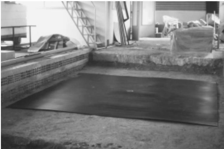
▲ Photo 3. – Aspect de la géomembrane avant mise en place du géotextile et de la couche granulaire, vue de la position du défaut (photo Cemagref)
