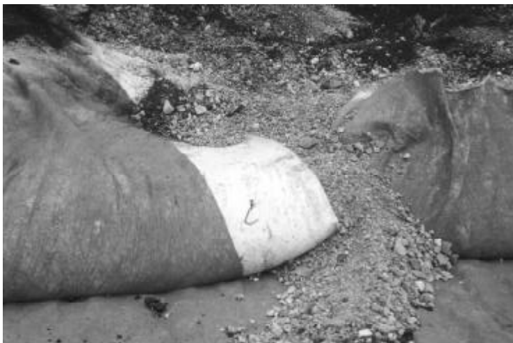
▲ Photo 2. – Géotextile amont : état du contact avec le parement aval et du recouvrement entre lés (photo J.P. Testemale).
