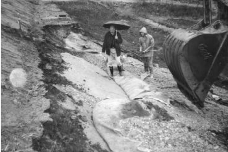
▲ Photo 1. – Début des travaux de réhabilitation de 1998 : destruction de la recharge aval de 1986, découverte et observations du drain granulaire amont et aval (photo P. Royet).
