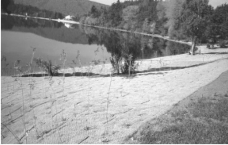
▲ Photo 1. – Le site d'Issarlès : mise en place des essais.
