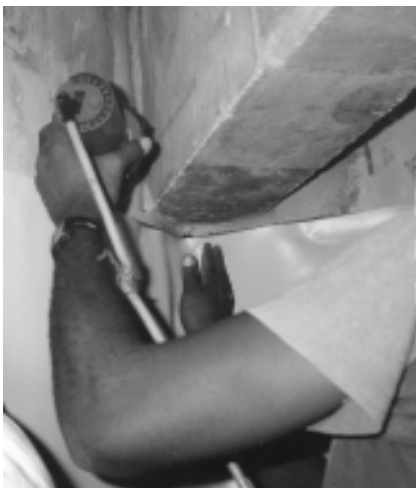
◀ Photo 3. – Réservoir de la Montagne Café – Soudure de la membrane d'étanchéité (photo D. Savoye).
