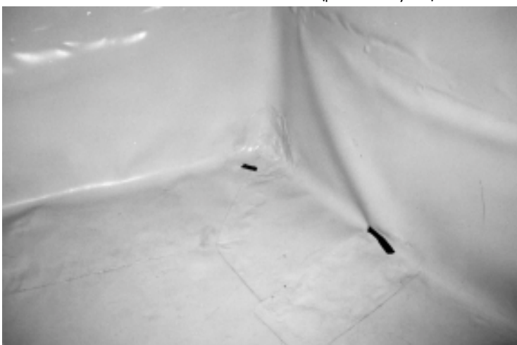
Photo 4. – Membrane d'étanchéité au contact de trois parois orthogonales (photo D. Fayoux). ▼
