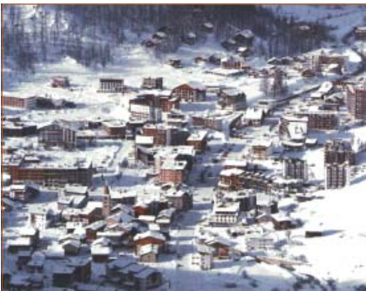
▼ Photo 2 – Exemple de diversité architecturale en montagne (Val-d'Isère).
