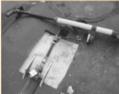
◀ Photo 3 – Contrôle en pression des doubles soudures (photo APAVE).
