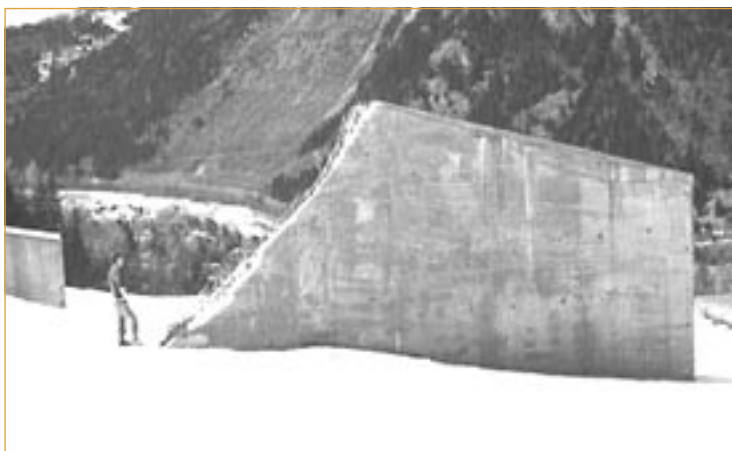
▲ Photo 2 – Une lame déflectrice en béton armé partiellement détruite par l'avalanche de Tacconnaz en 1999.
