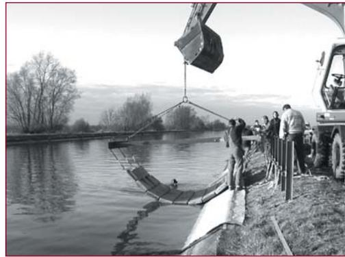
◀ Photo 4 – Mise en place d'un élément de pavés béton.
