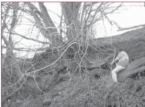
La partie supérieure du talus est alors soumise à un risque *généralisé de glissement*. En effet, l'apparente tenue des talus dans leur raideur actuelle n'est due qu'à leur maintien hors d'eau pendant 99 % du temps, et ne doit pas faire oublier une dégradation rapide des paramètres de stabilité lors d'une crue. On notera que **la configuration « pied dans l'eau » est particulièrement pénalisante** pour la digue puisque tout désordre en berge engage directement le talus de la digue.
