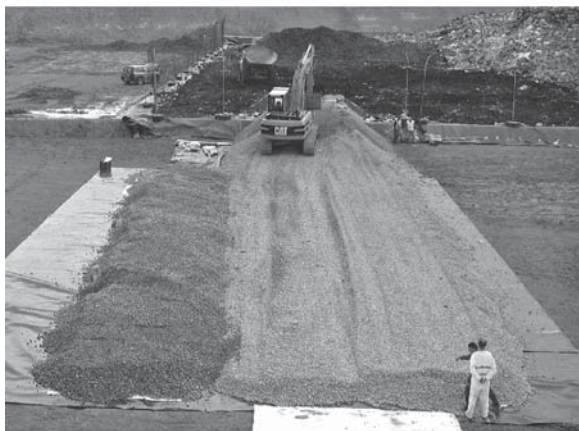
c- Mise en place des graviers roulés.
