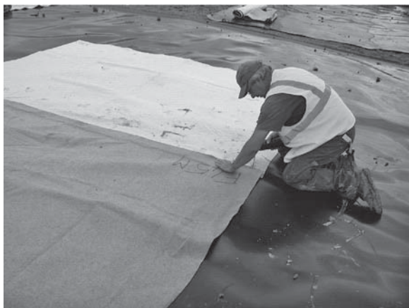
a- Soudure des géotextiles.
