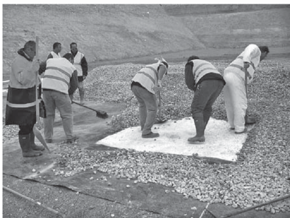
e- Enlèvement des graviers.
