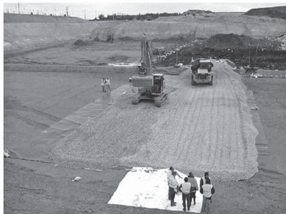
d- Circulation des engins (simulation des sollicitations de mise en œuvre).
