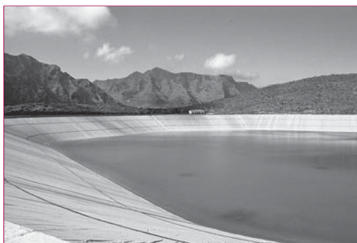
▲ Figure 2 – Vue du bassin de Montaña Del Taco.
