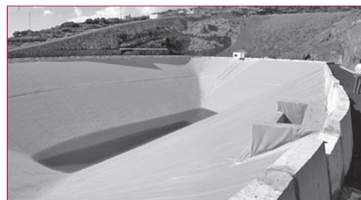
▲ Figure 7 – Bassin de Bedestia vu de l'aval. On remarque sur la droite le talus subvertical creusé dans le rocher et sur la gauche le talus renforcé par un soutènement en blocs cyclopéens. On aperçoit au fond la partie supérieure du talus aval d'Adeyahamen. Profondeur : 21 m, pente des talus : 1,5/1.
