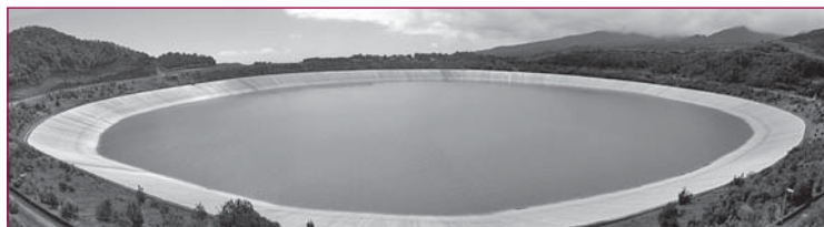
▼ Figure 3 – Le bassin de Barlovento en 2004, 13 ans, géomembrane PVC, 250 000 m 2 , diamètre 600 m.
