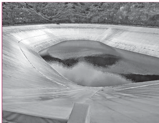
► Figure 6 – Bassin Adeyahamen partiellement vide ; profondeur : 26 m ; pentes : 1,5/1. On remarque le premier ancrage sur talus.
