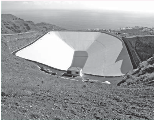
▲ Figure 8 – Bassin de Bedestia vu de la crête de la digue d'Adeyahamen. La route en pied de talus correspond au sommet du massif de pied de renforcement du talus aval de la digue d'Adeyahamen. On observe à droite le renforcement de talus par un mur en blocs cyclopéen.
