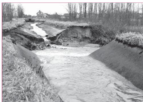
▲ Figure 2 – Rupture des digues de la rigole de l'Arroux (DDE Saône et Loire).
