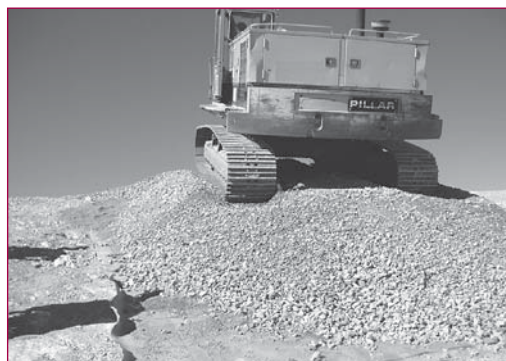
▲ Figure 4 – Planches d'essai : circulation de la pelle hydraulique sur le DEG.
