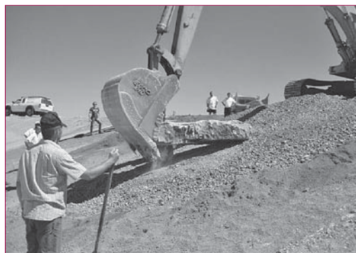
▲ Figure 6 – Planches d'essai : mise en place d'une dalle calcaire.
