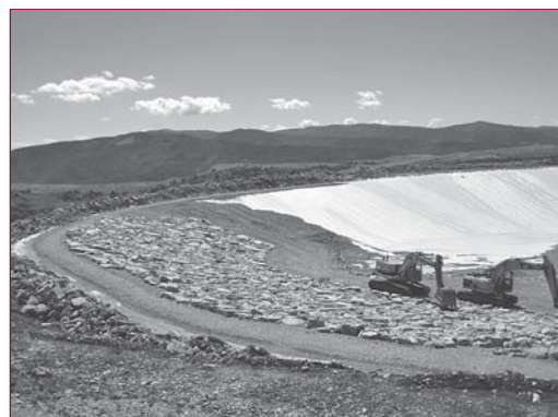
▲ Figure 7 – Vue du bassin en cours de réalisation.
