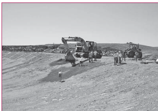
▲ Figure 3 – Planches d'essai : « surfacage » du fond de forme à l'aide de sable.
