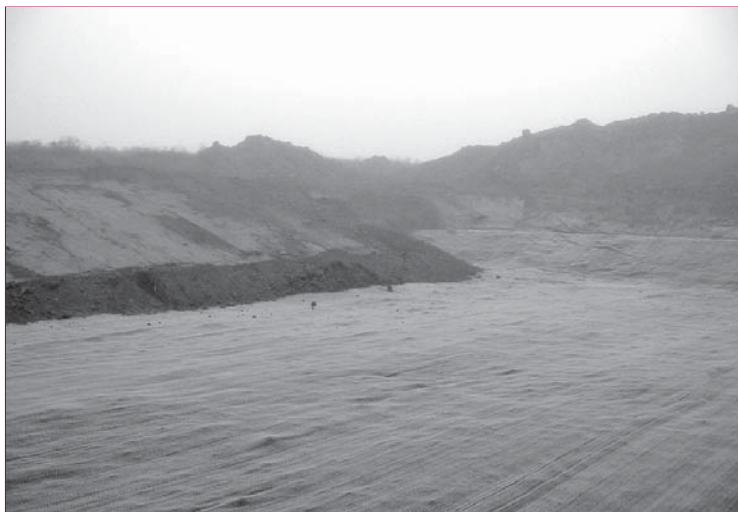
▲ Figure 1 – Vue du GSB après la pose et avant le confinement.
