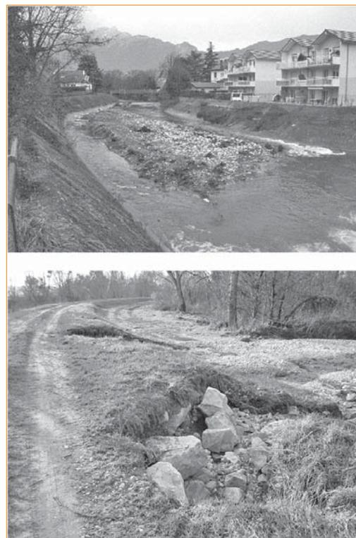
▲ Figure 10 – En haut : endiguement en béton sur les deux berges en zone urbanisée. En bas : digue en enrochements + remblai (sapée par déversement) en zone rurale (la rivière est à gauche).
