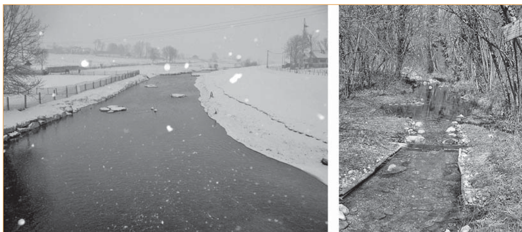
▲ Figure 2 – Exemples de petits aménagements piscicoles de type R1 : a) installation de blocs dans le cours d'eau pour créer à la fois des abris hydrauliques pour les poissons adultes (généralement de truites) et éventuellement des zones de reproduction dans les dépôts de graviers qui se font entre les blocs ; b) vue en plan d'installation de sous-berges artificielles pour créer des caches pour les poissons adultes ; c) vue en coupe (FAO 4 , 1998).
