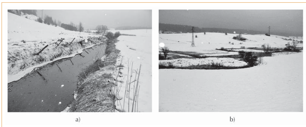
► Figure 6 – Exemple de restauration fonctionnelle de niveau R3. Reméandrage d'un petit cours d'eau rectifié dans les années 60 : a) amont non restauré ; b) aval restauré (l'ancien tracé rectiligne est bien visible à la corde des méandres).
