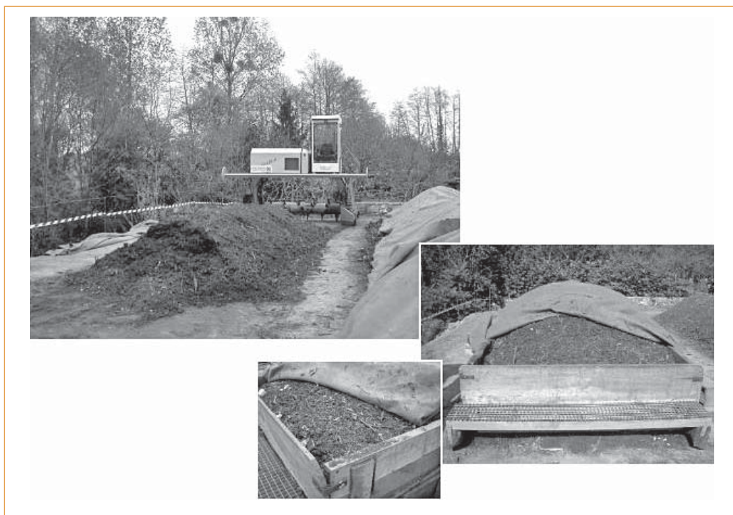
► Photo 4 – Plate-forme de compostage de proximité de proximité de St-Philbert-de-Bouaine.
