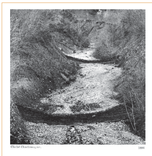
► Figure 4 – Clayonnages dans le torrent de l'Echarina, Isère (Kuss, 1903).
