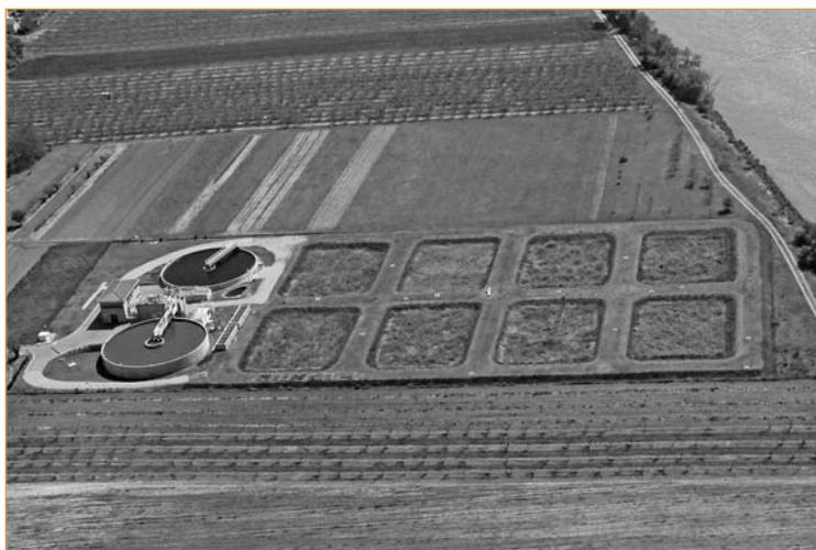
▲ Photo 1 – Vue aérienne de la station d'épuration d'Andancette (Drôme) avec les huit lits de séchage en taille réelle et les seize pilotes de 2 m<sup>2</sup> chacun pour les essais sur les matières de vidange et les boues seules et en mélange.
