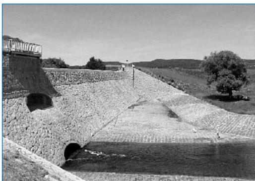
▲ Photo 2 – Parement aval de la retenue de Sobieszów, partie centrale maçonnée avec fosse de dissipation.
