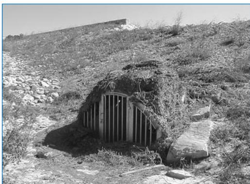
▲ Photo 7 – Bassin du terrain de l'Armée ; grille en forme de tunnel protégeant le pertuis ; on peut remarquer que la partie verticale n'a pas été obstruée par les flottants déposés à la décrue.
