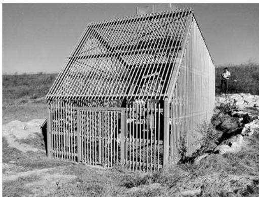
◀ Photo 8 – Bassin de l'aérodrome ouest : grille de protection des vannes à flotteur à l'entrée des conduites.
