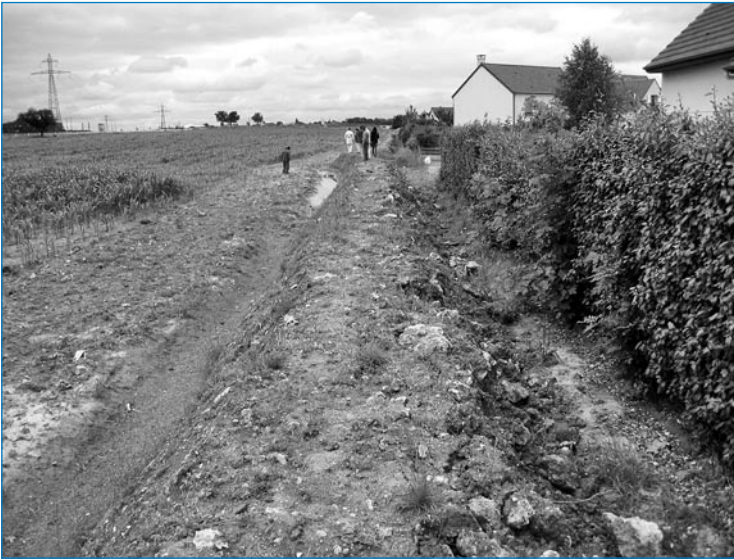
▲ Photo 1 – Talus en terre réalisé après l'orage, pour protéger des pavillons inondés (commune de Villiers-le-Bâcle, Essonne).
