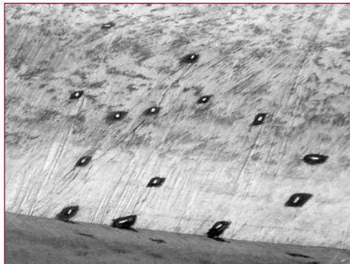
▲ Photo 5 – Nombreuses perforations de la géomembrane par effet de robotage par la glace.
