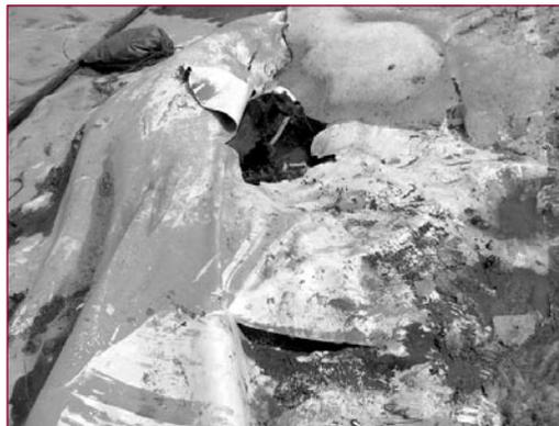
▲ Photo 4 – Chutes de blocs de glace ayant entraîné des déchirures décimétriques de la géomembrane en fond de retenue.
