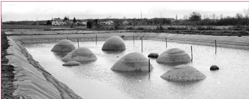
◀ Figure 5 – Bassin de lagunage en zone marécageuse : le drainage en fond de bassin est noyé et les gaz ne peuvent donc pas s'échapper sur les côtés, même avec des drains supposés leur faciliter la sortie.
