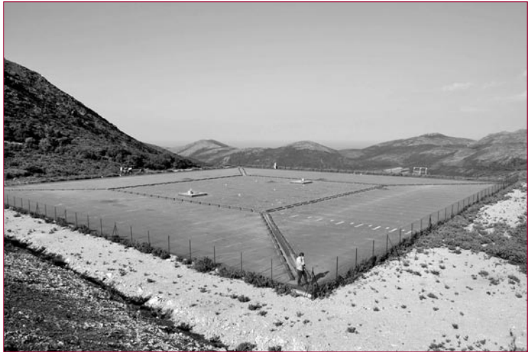
▲ Figure 11 – Réservoir souple d'Ersa 15 000 m 3 , plein. On observe les gorges de mise en tension (remplies d'eau), les deux trappes de visite et les six évents.
