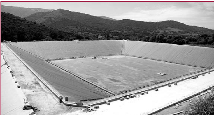
▼ Figure 13 – Cargèse – Vue d'ensemble du bassin 1, couverture en cours de finition.
