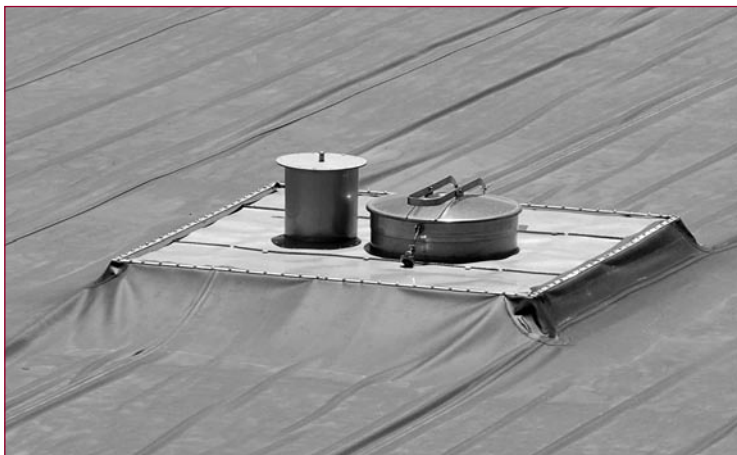
▲ Figure 9 – Trappe de visite (bassin de Cargèse).
