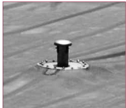
▲ Figure 6 – Évent en fond de couverture (Cargèse).
