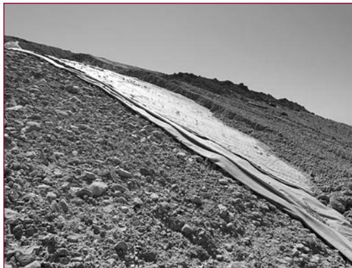
▲ Figure 5 – Mise en œuvre de la terre végétale sur le complexe géosynthétique.
