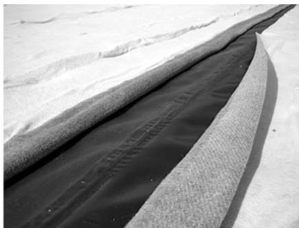
◀ Figure 3 – Soudure par fusion de la membrane pour garantir l'imperméabilisation.
