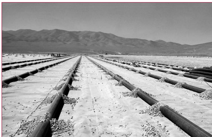
▼ Figure 4 – Tuyaux annelés en PEHD pour le drainage d'une zone d'extraction de métaux (d'après Touze-Foltz et al. , 2008).
