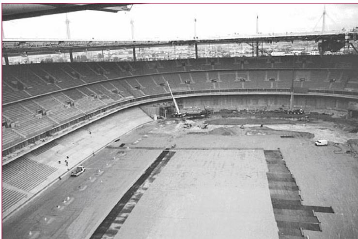
Dans le cas du Stade de France (cas n° 9 et figure 10), ce dispositif comprend des géosynthétiques de drainage et un pompage écrémage des hydrocarbures de la nappe sous-jacente, en plus du captage des gaz.
