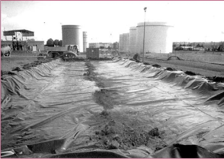
◀ Figure 5 – Dispositif basal d'un biotertre comportant un géofilm en polyéthylène (site industriel ; photo Arcadis).
