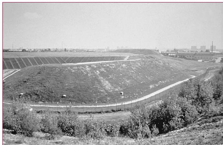
▲ Figure 4 – Le « Grand terail de Cr VI » de Watrelos : au premier plan, son annexe, rapportée en 1998, est un confinement « hors site » par géomembrane bitumineuse (in : Ballie *et al.*, 1999).
