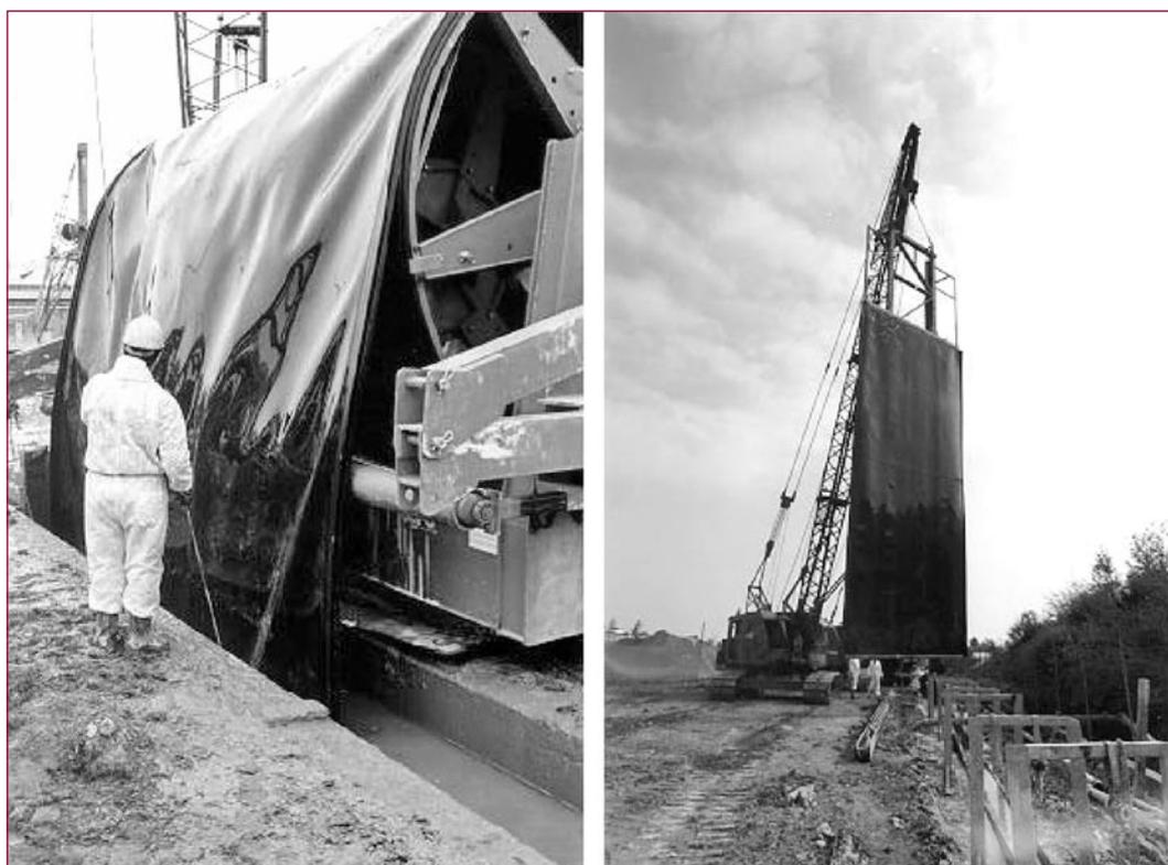
◀ Figure 8 – Deux dispositifs de mise en œuvre de géomembrane PEHD en parois : enroulement et palfeuilles (photos : Agru France).
