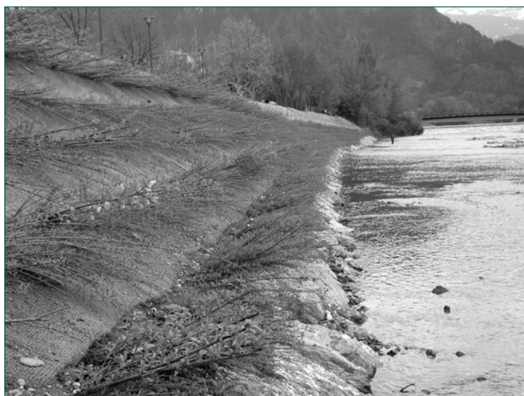
▲ Photo 2 – Lorsque les contraintes sont fortes, les techniques dites mixtes sont nécessaires. On voit ici, sur un cours d'eau dynamique, un enrochement de pied de berge surmonté d'un lit de plants et plançons.
