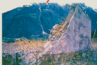
Ouvrages de protection endommagés Dents défectives de Taconnaz (Chamonix, Les Houches, France)
