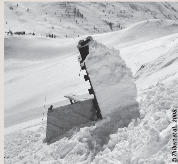
10b Dépôt de neige sur la structure
