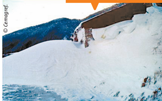
① Congère générée par un bâtiment et bloquant une route.
