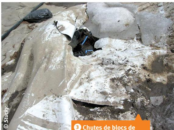
3 Chutes de blocs de glace ayant entraîné des déchirures décimétriques de la géomembrane en fond de retenue.
