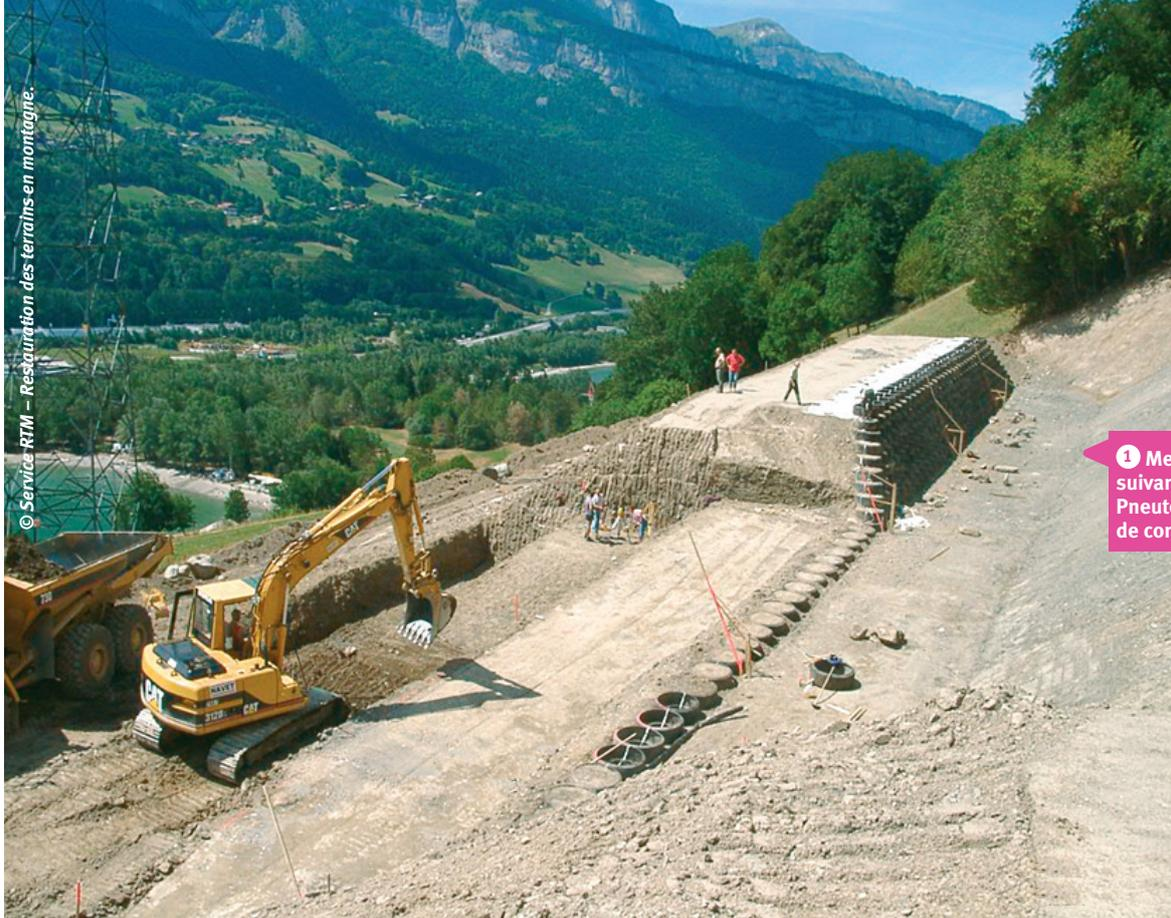
1 Merlon pare-blocs, suivant le procédé Pneutex®, en cours de construction.
