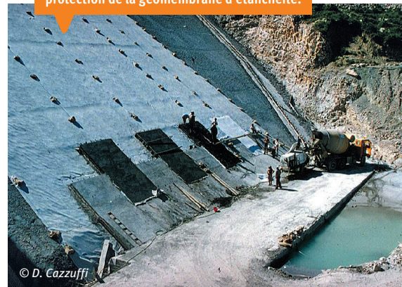
❶ Barrage de Bovilla pendant la mise en place de couches de béton comme protection de la géomembrane d'étanchéité.
