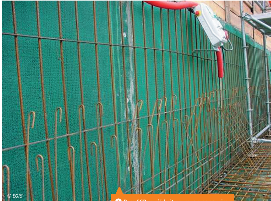
6 Pose GSB en piédroit- ouvrage avec emprise.
