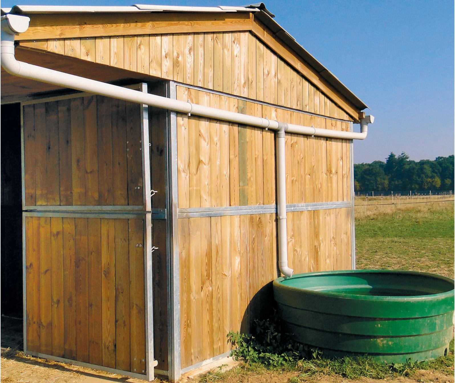
*Les eaux de pluie collectées dans les réservoirs de récupération par le biais des toitures sont souvent utilisées pour l'arrosage du jardin.*
