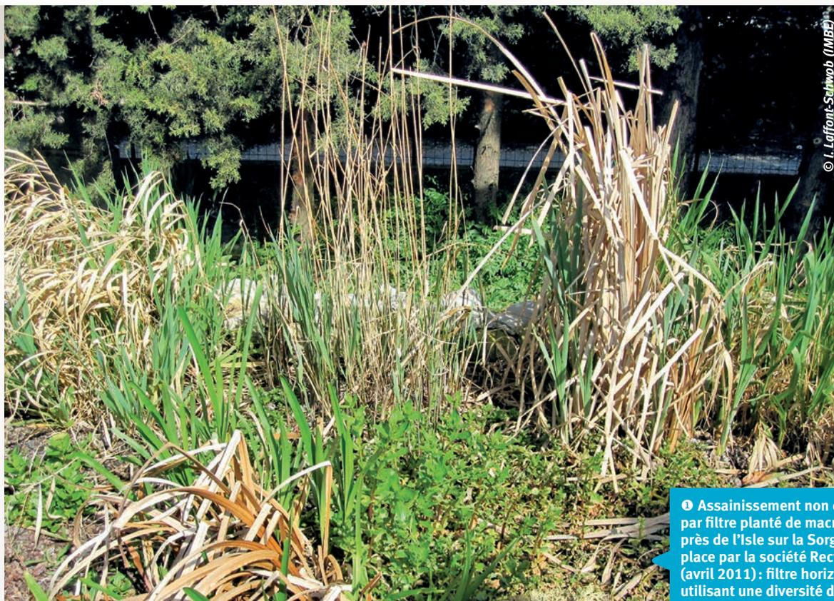
❶ Assainissement non collectif par filtre planté de macrophytes près de l'Isle sur la Sorgue mis en place par la société Recycl'eau (avril 2011) : filtre horizontal utilisant une diversité d'hélophytes en aval d'un filtre planté vertical.
