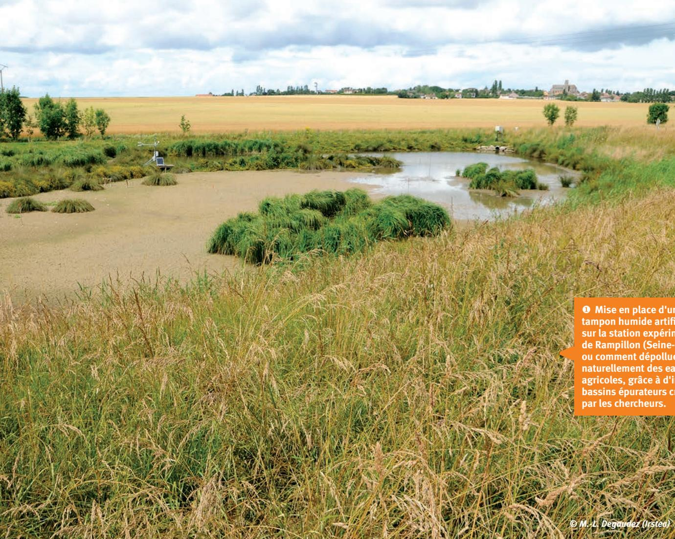
❶ Mise en place d'une zone tampon humide artificielle sur la station expérimentale de Rampillon (Seine-et-Marne) ou comment dépolluer naturellement des eaux agricoles, grâce à d'ingénieux bassins épurateurs créés par les chercheurs.
