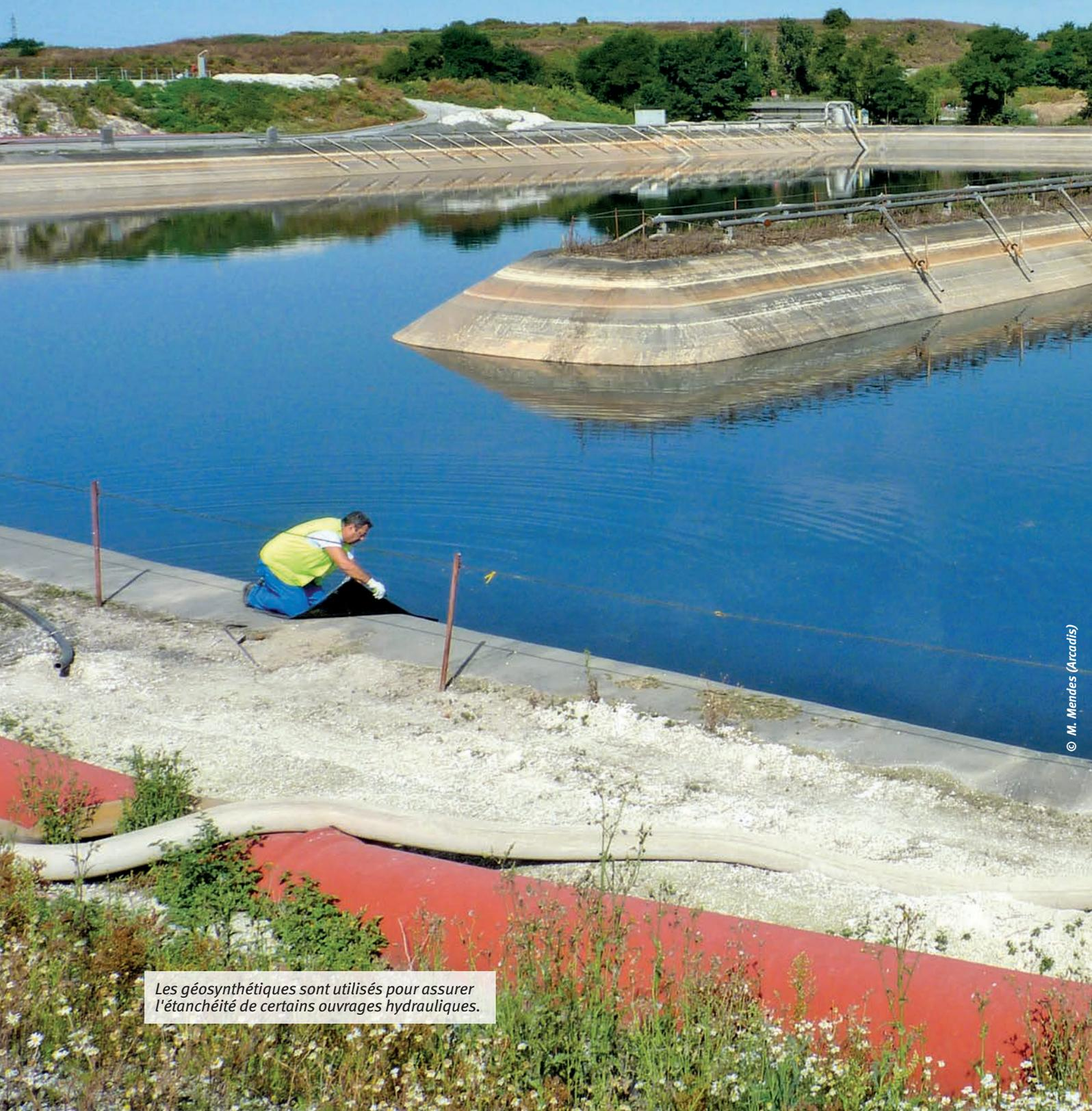
Les géosynthétiques sont utilisés pour assurer l'étanchéité de certains ouvrages hydrauliques.
