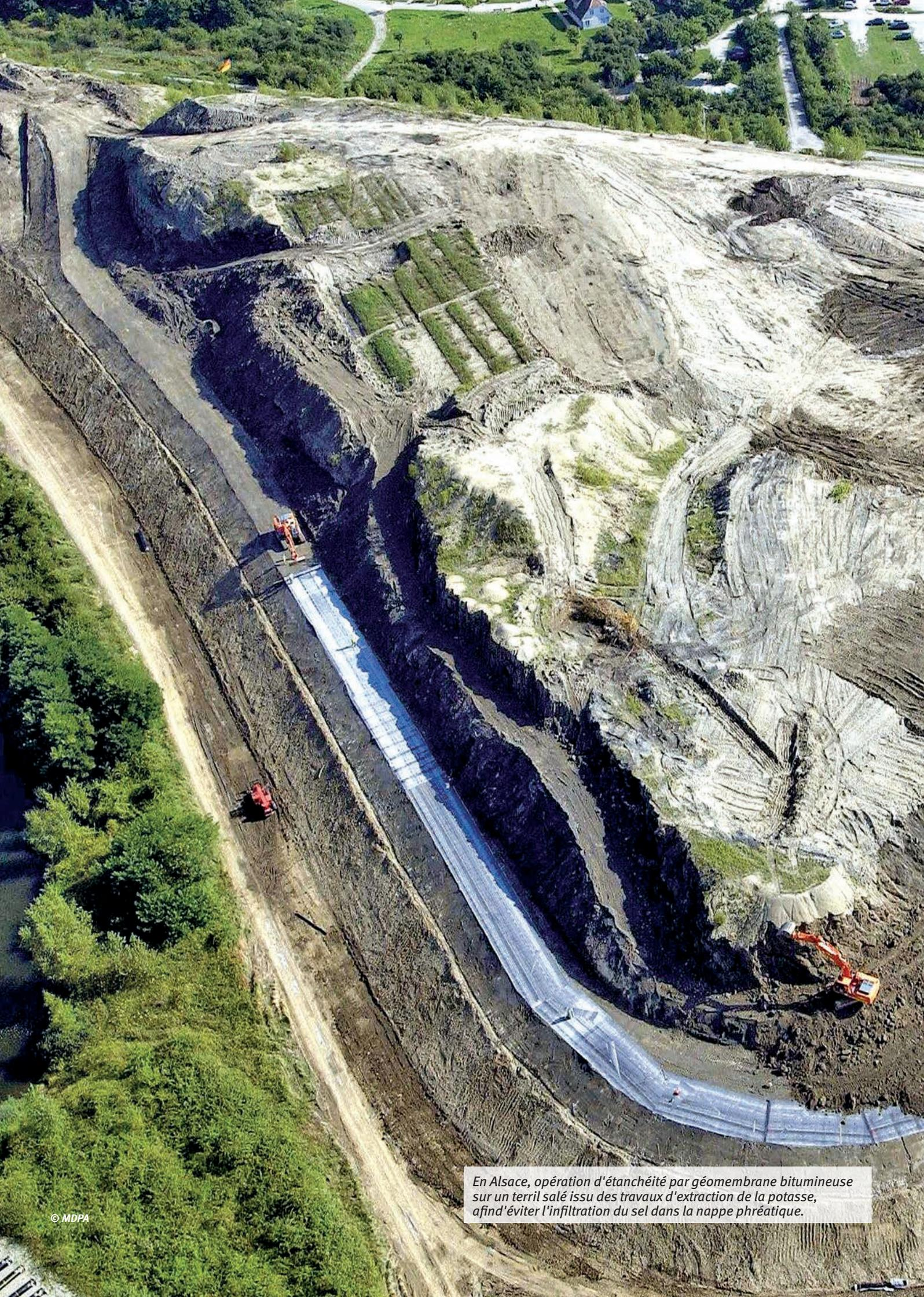
*En Alsace, opération d'étanchéité par géomembrane bitumineuse sur un terril salé issu des travaux d'extraction de la potasse, afin d'éviter l'infiltration du sel dans la nappe phréatique.*
