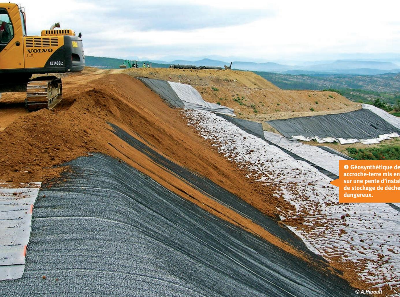
❶ Géosynthétique de type accroche-terre mis en place sur une pente d'installation de stockage de déchets non dangereux.
