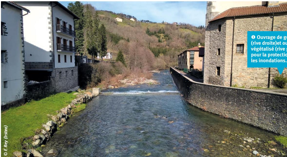
① Ouvrage de génie civil (rive droite) et ouvrage mixte végétalisé (rive gauche) pour la protection contre les inondations.
