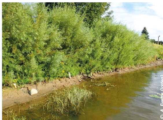
② Protection d'une berge initialement érodée par le batillage, stabilisée avec un matelas de branches. La photo a été prise trois ans après les travaux, dans la région de Lanaudière près de Montréal.
