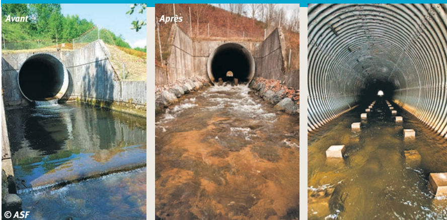
1 Présentation de la buse avant travaux (à gauche) et après travaux (au centre et à droite).
